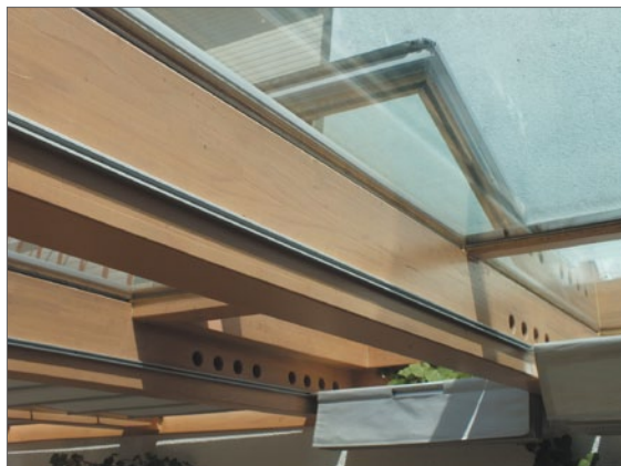
Löcher am Firstpunkt der Dachsparren: Aus allen Glasfeldern kann gestaute Warmluft zum Entlüftungsfügel strömen.
